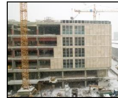
Gewerk z. B. Fassade
