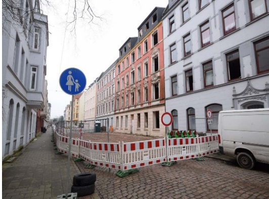
Abb. 03: Objekt Heinrichstraße 34, Originalbau, vor dem Abriss (Quelle: FORUM Huebner, Karsten & Partner)
