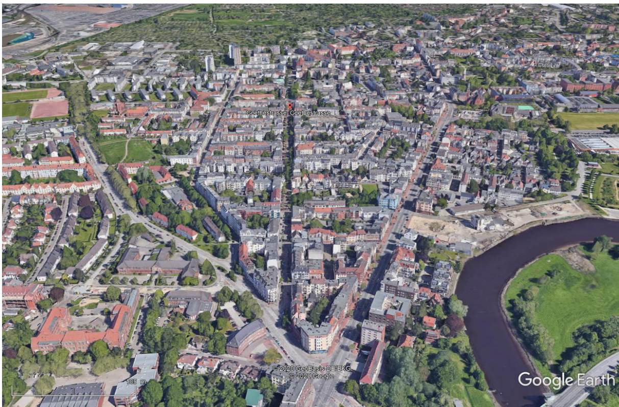
Abb. 01: Luftbild des Quartiers Goethestraße im Stadtteil Bremerhaven-Lehe (Quelle: Google Earth, 24.03.2020)
