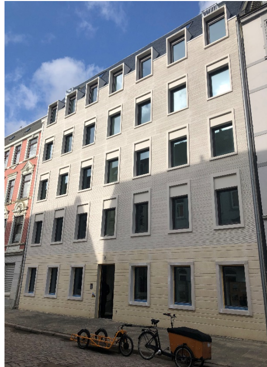
Abb. 08: Objekt Heinrichstraße 34, Neubau Straßenfassade (Quelle: IFB)
