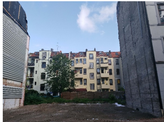
Abb. 06: Baulücke Heinrichstraße 34 (Quelle: FORUM Huebner, Karsten & Partner)
