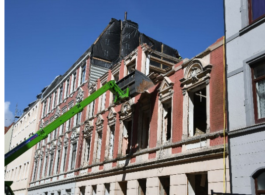
Abb. 04: Objekt Heinrichstraße 34, während der Abrissarbeiten (Quelle: FORUM Huebner, Karsten & Partner)
