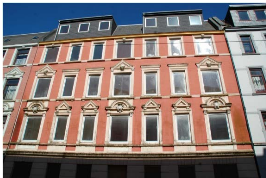
Abb. 09: Objekt Heinrichstraße 34, Originalbau, vor dem Abriss (Quelle: FORUM Huebner, Karsten & Partner)
