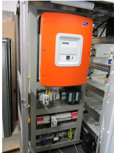
Abbildung 1.7: SMA Wechselrichter Sunny Island 5000 GS und Elektronik
