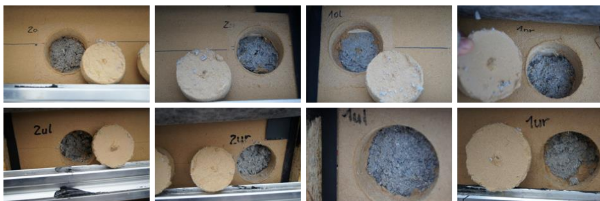
BILD 9-21 ZUSTAND DER SCHICHTGRENZE GEFACHDÄMMUNG / AUßENSEITIGE GEFACHBEPLANKUNG AN GEFACH 1 UND 2 AM 24.01.2013
