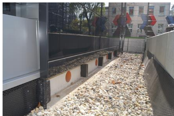
BILD 4-2 KRIECHKELLER IN DER BAUPHASE UND NACH GEBÄUDEFERTIGSTELLUNG – LÜFTUNGSÖFFNUNGEN IN DEN STREIFENFUNDAMENTEN
