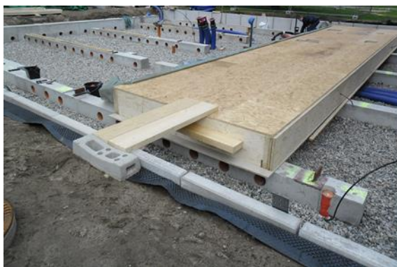
BILD 4-2 KRIECHKELLER IN DER BAUPHASE UND NACH GEBÄUDEFERTIGSTELLUNG – LÜFTUNGSÖFFNUNGEN IN DEN STREIFENFUNDAMENTEN
