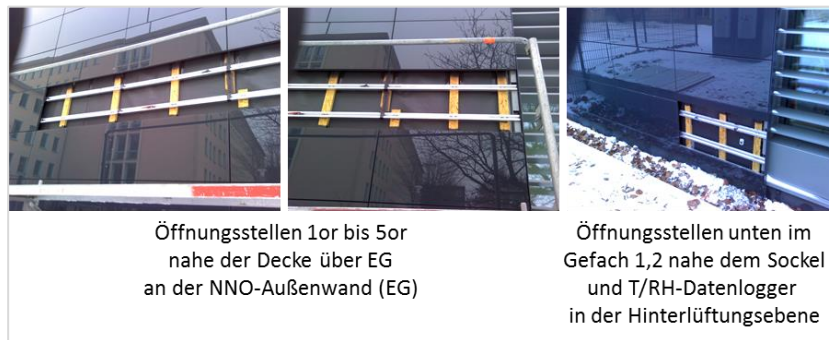
BILD 9-15 KURZZEITIGE DEMONTAGE EINZELNER GLASFASADENELEMENTE DER VORHANGFASADE AN DER NNO-AUßENWAND FÜR UNTERSUCHUNGEN AN DER SCHICHTGRENZE GEFACHBEPLANKUNG / ZELLULOSE-GEFACHDÄMMUNG AN 5 GEFACHEN
