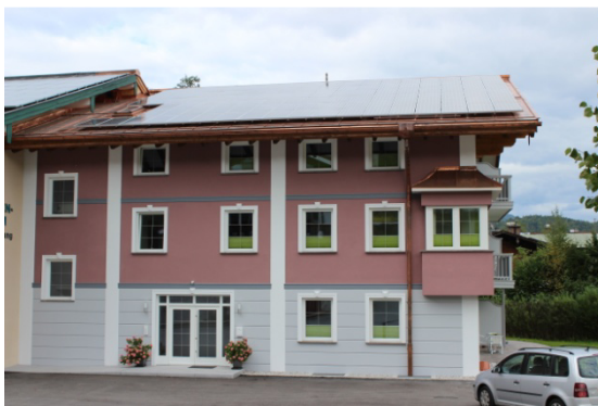
Abbildung 3: Photovoltaik-Anlage auf Dachfläche Südwest
