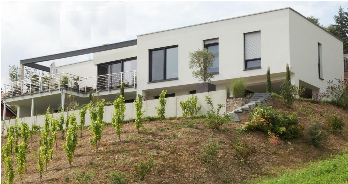
Abbildung 1: Effizienzhaus Plus Buchen-Hollerbach, Außenansicht der Süd-Ost-Seite
