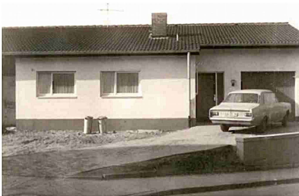
Frontansicht des Gebäudes im unsanierten Zustand
