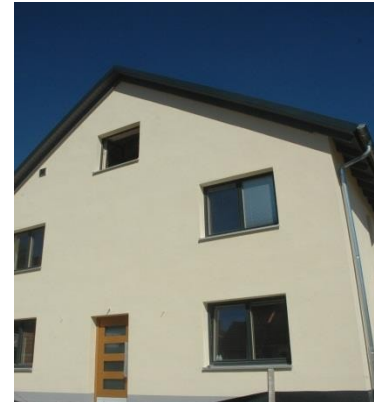
Westansicht Effizienzhaus Plus
