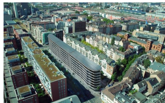
Aktiv-Stadthaus in der Speicherstraße, Frankfurt
