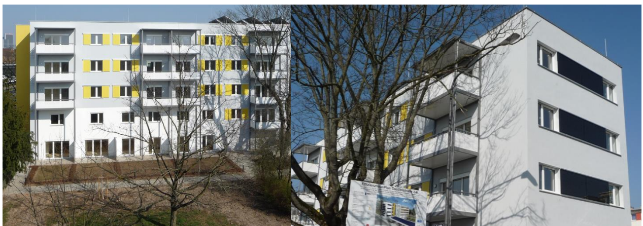
Bild 1: Westansicht des Gebäudes
