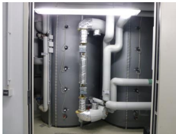
Bild 13: Diaphragmalektrolyse (links) und Pufferspeicher Wärme (rechts)
