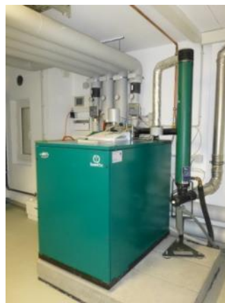
Bild 12: Wärmeerzeugung durch Solarthermie (links) und Biomethan-BHKW (rechts)
