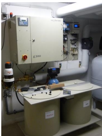
Bild 13: Diaphragmalektrolyse (links) und Pufferspeicher Wärme (rechts)
