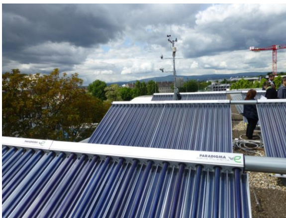
Bild 12: Wärmeerzeugung durch Solarthermie (links) und Biomethan-BHKW (rechts)
