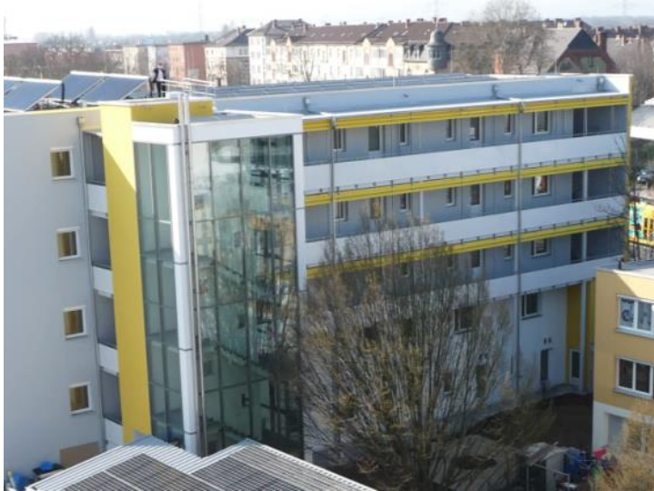
Bild 3: Ostansicht des Gebäudes mit Laubengangerschließung
