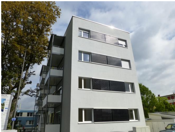
Bild 7: Südsansicht des Gebäudes mit fassadenintegrierter Photovoltaik
