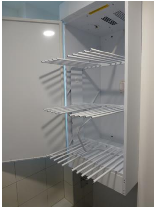
Bild 14: Trockenschrank im Badezimmer jeder Wohnung
