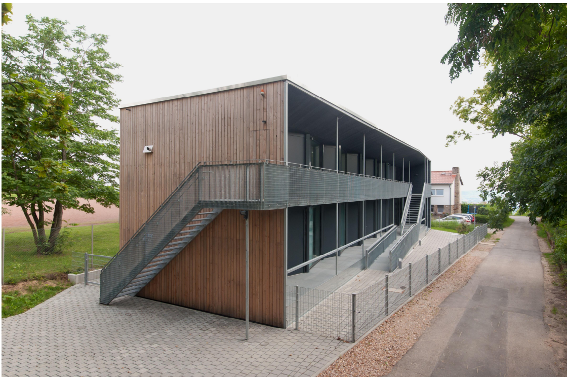
Abb. 2 Nord-West-Ansicht Effizienzhaus Plus Geisenheim, Quelle: Quelle: DGJ Architektur GmbH
