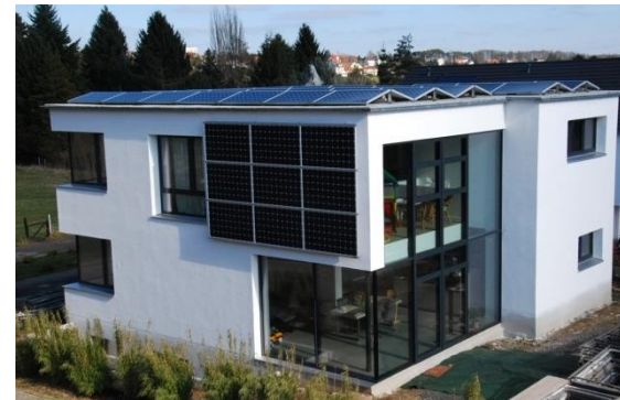
Süd-Westansicht Effizienzhaus Plus Kassel
