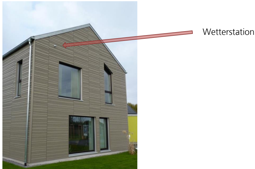
Bild 11: Anordnung der Wetterstation an Südfassade Gebäude.
