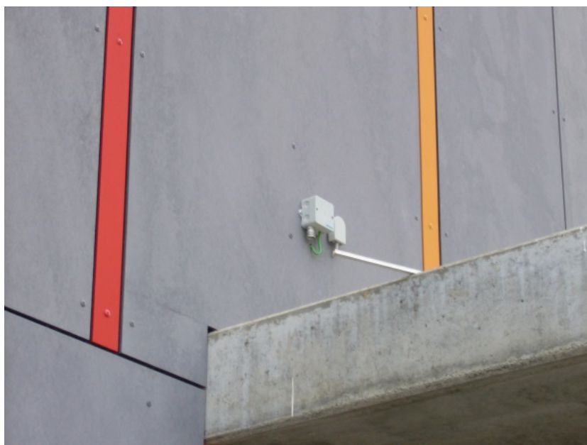
Abbildung 23: Außenfühler für Temperatur und relative Feuchte [Erhart].
