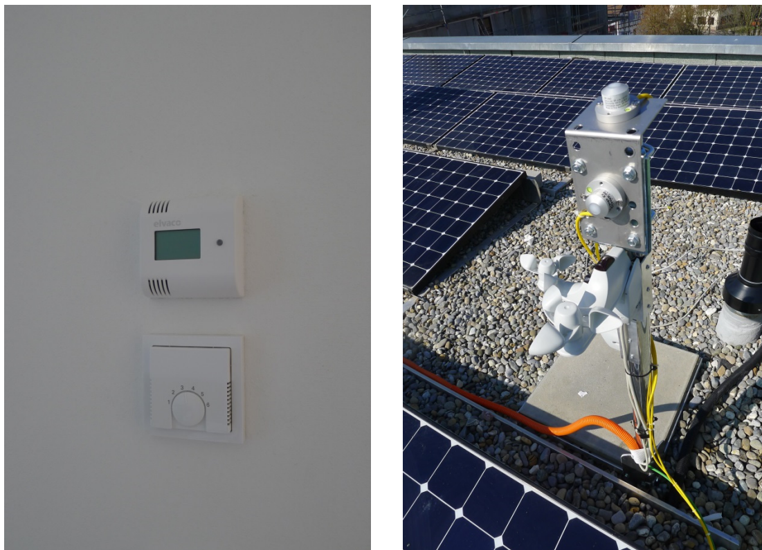
Abbildung 24: (a) Behaglichkeitssensoren /- (b) Einstrahlungssensoren [Erhart].
