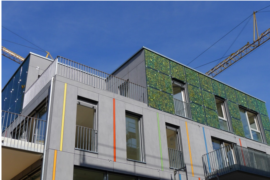
Abbildung 12: Eckansicht mit beiden Fassadenkollektoren [Erhart].
