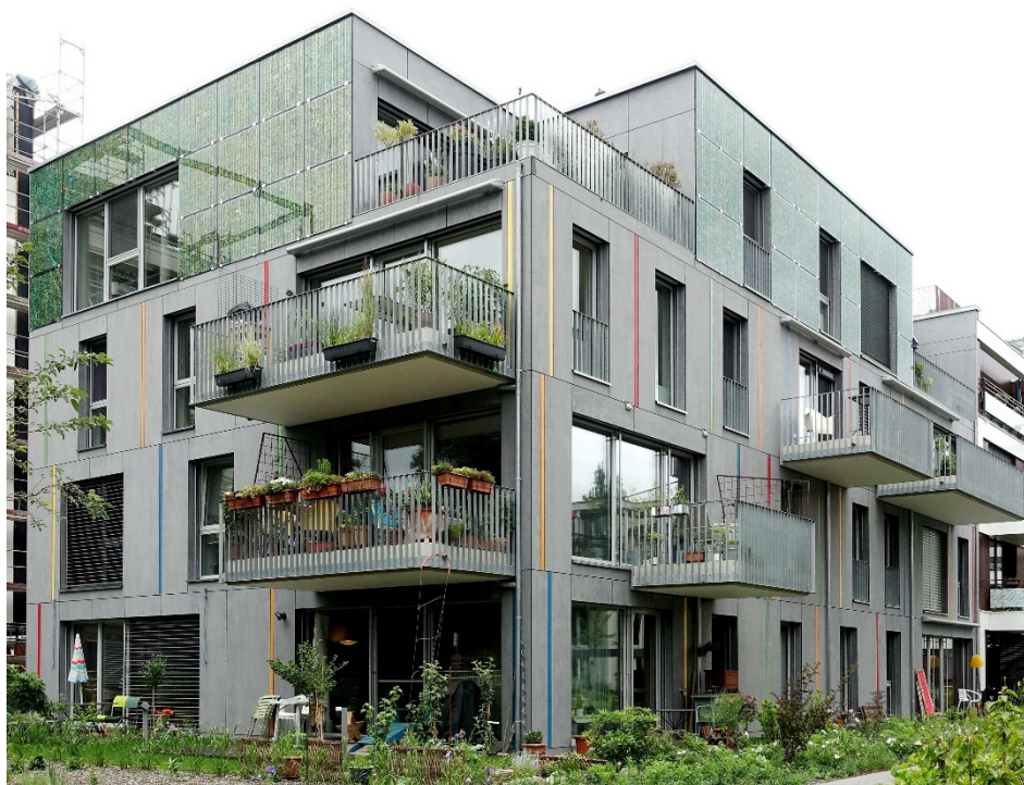
Abbildung 3: Modellvorhaben Licht&Luft in Tübingen-Lustnau, Eckansicht S0 [Architekt Wamsler].
