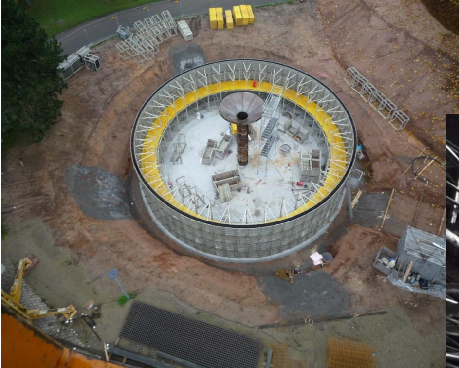
Bauarbeiten der Wand des Eisspeichers
