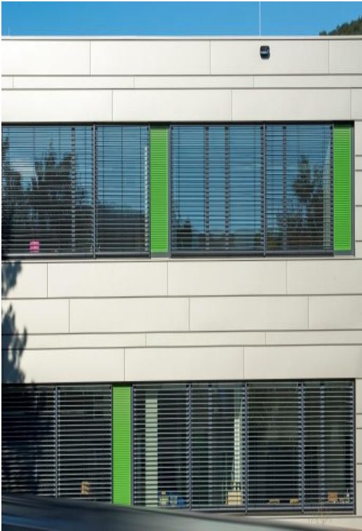
Fassadenansicht – mit farbigen Elementen für die Lüftungsgitter
